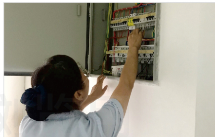
发现燃气泄漏禁止开关电器
