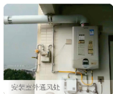
安装室外通风处
