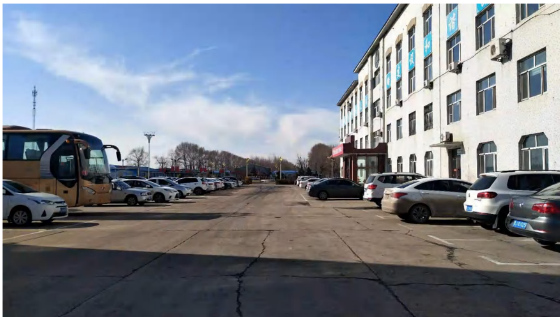
照片 3-1 现场调查（厂区办公楼）
