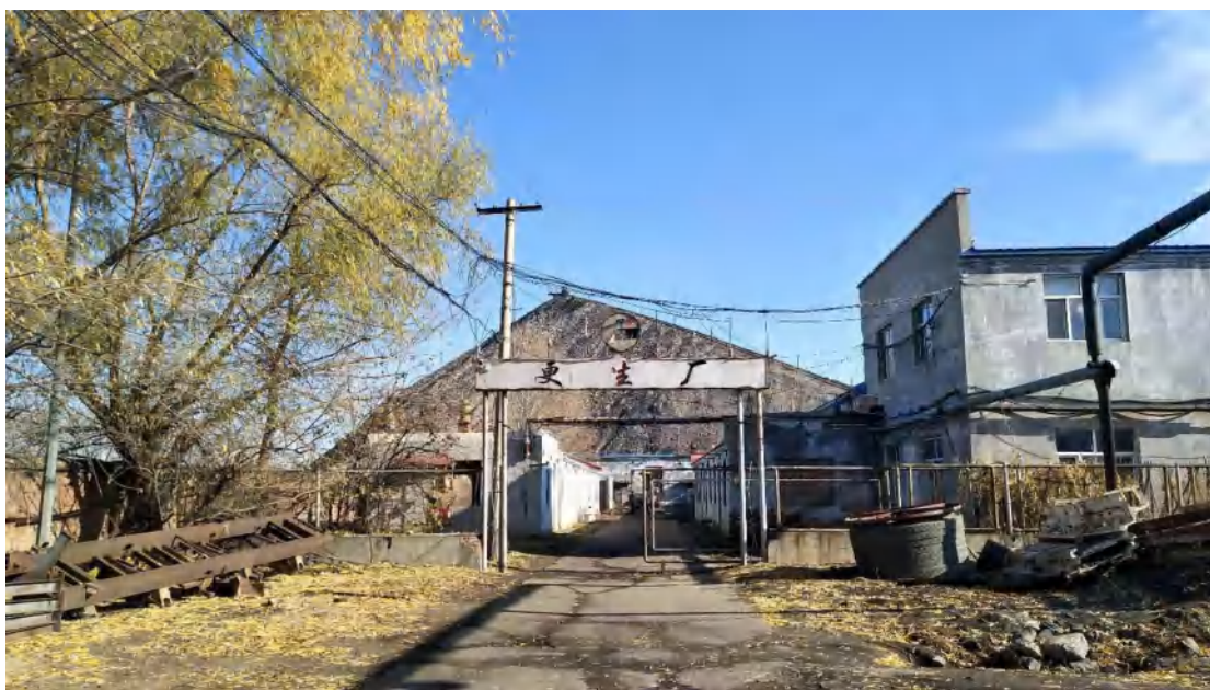
照片 3-6 工业广场内矸石山
